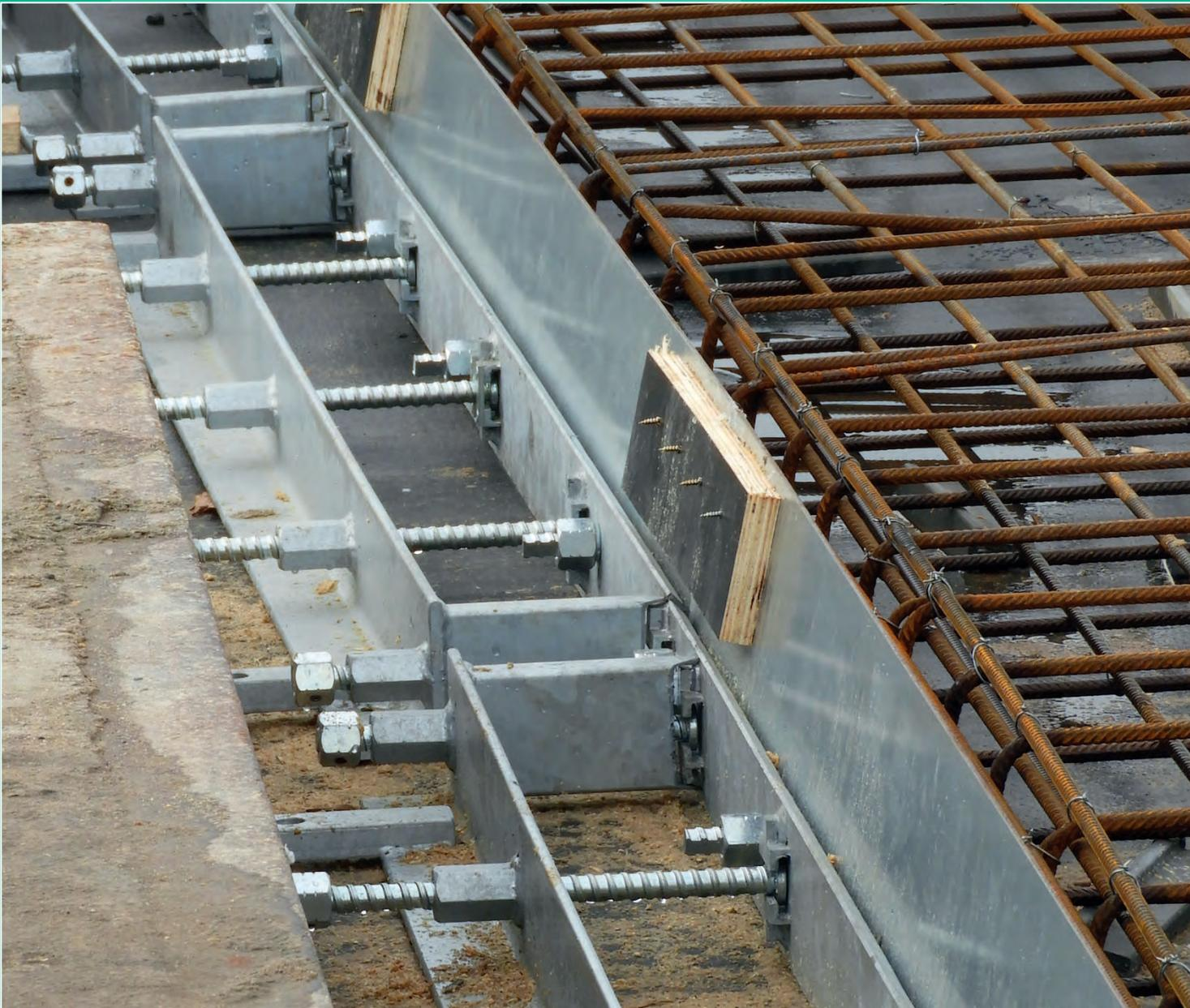
Übersicht Kappeneinbauteile und Schalsysteme
