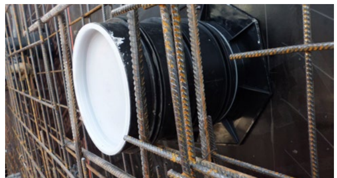
UFR in Schalung
