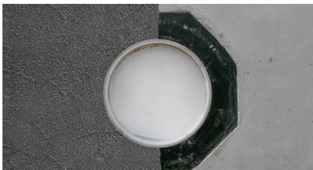
Betoniertes UFR mit PMBC
