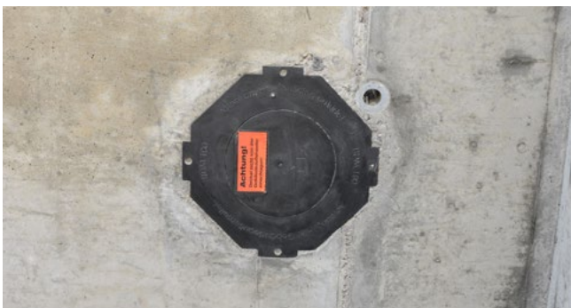
Praxisbild UDM/UDME in betonierter Wand
